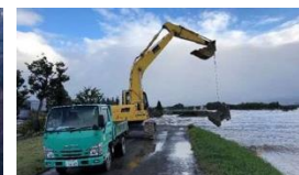
水防団員による水防活動（月の輪工法）
