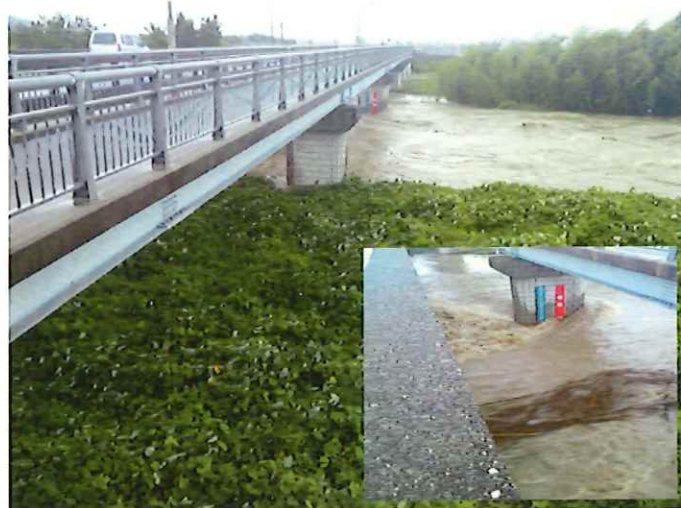
日野川桐原橋の状況
