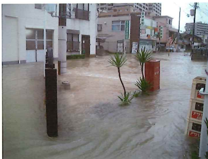
野洲駅前交差点北側の冠水状況
