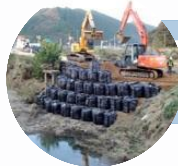
決壊した堤防を土のうを積んで応急復旧
