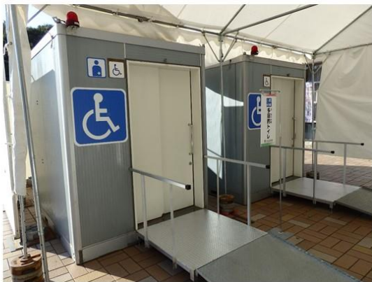
仮設の多目的トイレ
