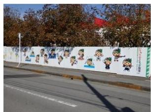
工事仮囲いへの装飾(宇都宮市)
