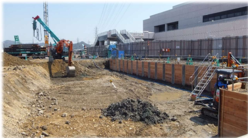
土留めをした後に、掘削をしています
