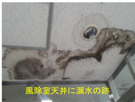
風除室天井に漏水の跡
