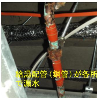
給湯配管（銅管）が各所で漏水
