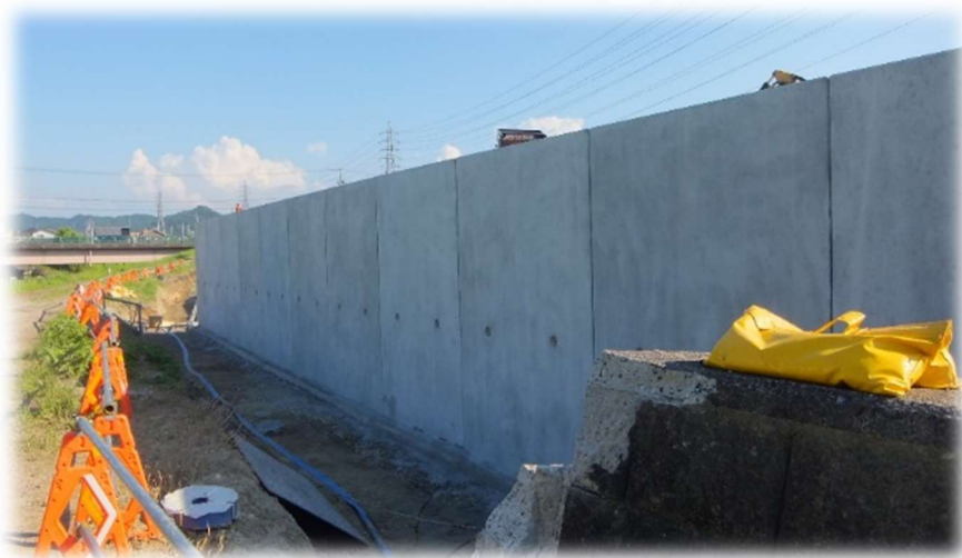
↑ 設置中の新擁壁（左が中ノ池川）
