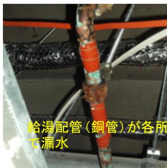
給湯配管（銅管）が各所で漏水
