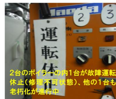
2 台のボイラーの内 1 台が故障運転停止（修理不可状態）、他の 1 台も老朽化が進行中
