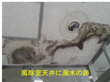
風除室天井に漏水の跡
