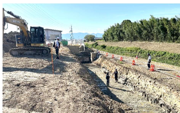
擁壁設置工事が進んでいます
