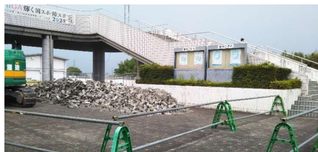
屋外階段周辺の様子
