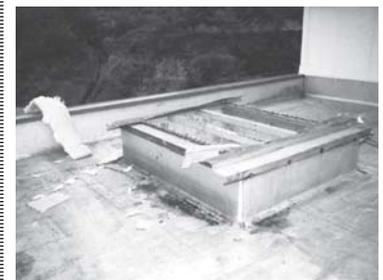
爆発事故によって破損した粗大ごみ処理施設の爆風口
