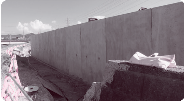
擁壁を設置しています
