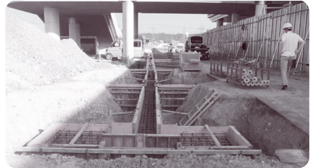
体育館の外階段の基礎を設置しています
