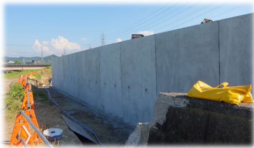
↑ 設置中の新擁壁（左が中ノ池川）
