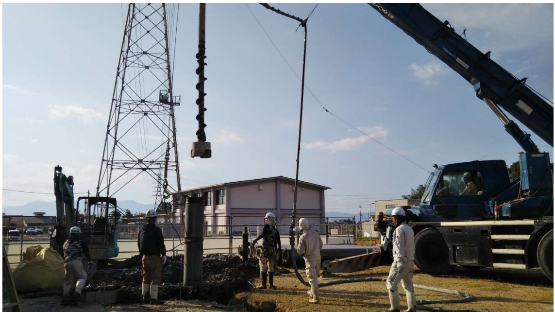
8月2日 屋外階段 試験杭
