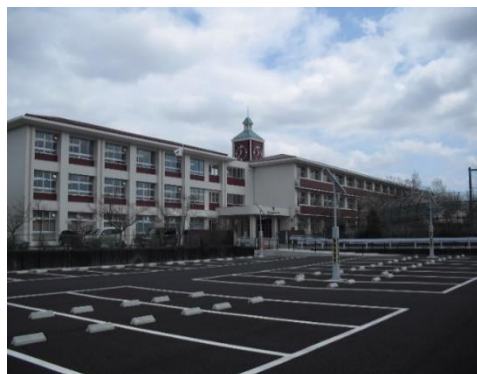
（きれいに改修された野洲北中学校）
