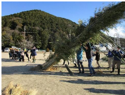
②6年生が引張って竹組を起こします。倒れないように、周りを竹で支え、四方に打ったくいに番線をとめます。
