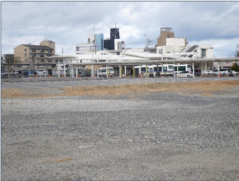
野洲駅南口周辺の状況
