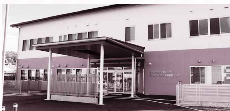
発達支援センター駐車場等工事
