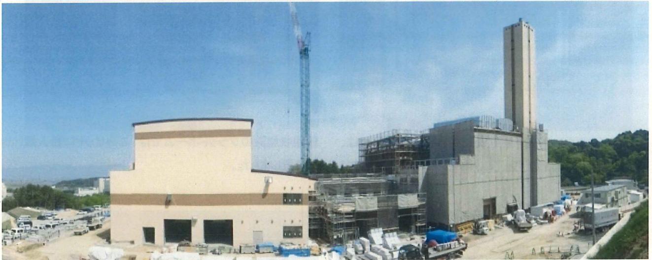
新野洲クリーンセンター建設工事現場の状況(平成 28 年 4 月末時点)
