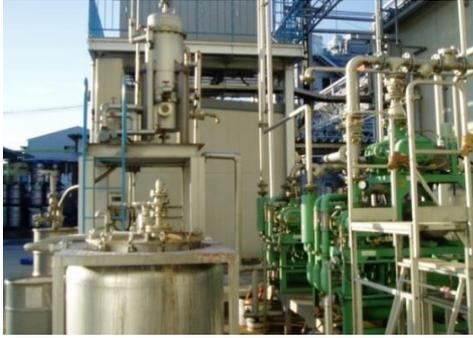
真空ポンプ排気口に脱臭装置を設置して、プロセスガスを凝縮し、臭気抑制を行っています。
