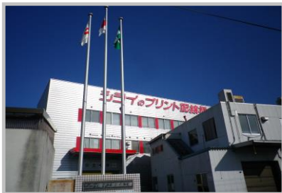
富波工場正面付近
