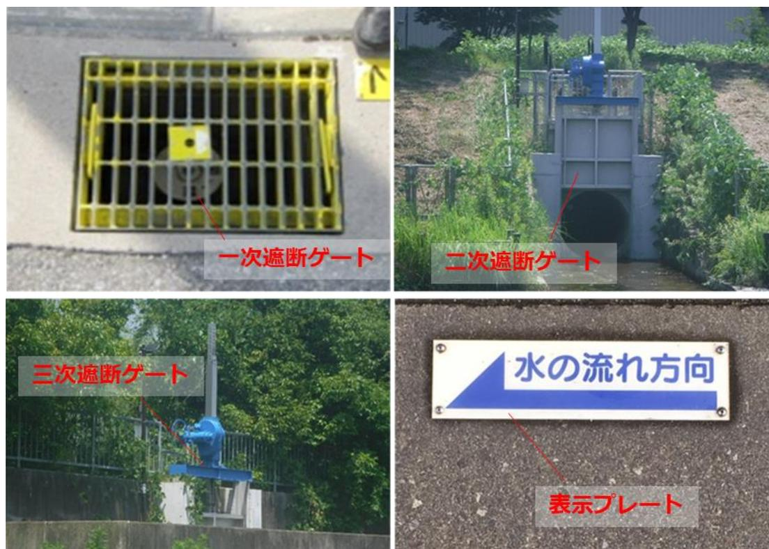
図. 種々の遮断ゲートと流れ方向の表示プレート
