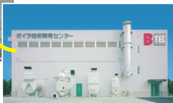
・ボイラ技術開発センター「B-TEC」
