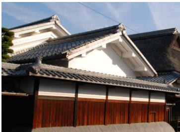
漆喰壁と焼き板壁
