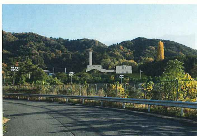
既存施設撤去後
