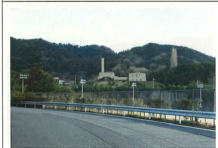
既存施設撤去後
