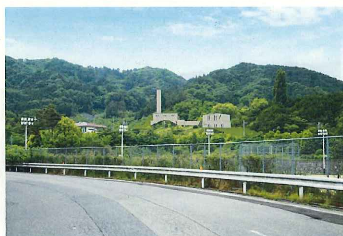
既存施設撤去後
