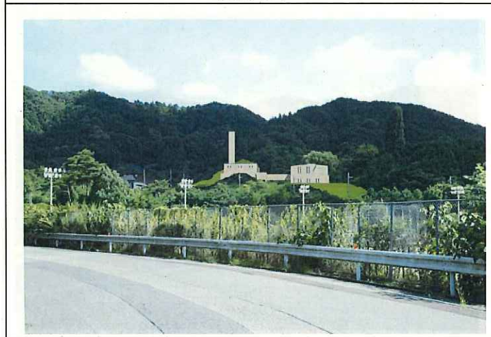
既存施設撤去後
