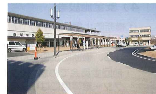
半たわみ性舗装の施工例
