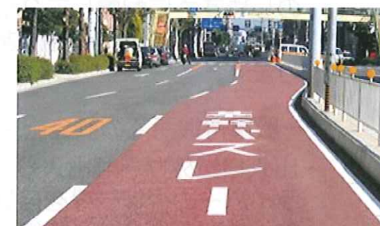
赤系色の車道舗装施工例
