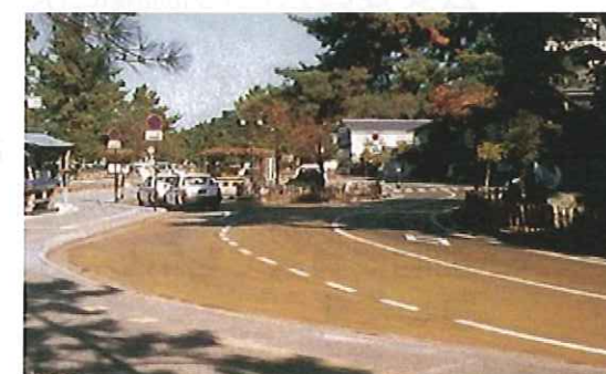
黄系色の車道舗装施工例
