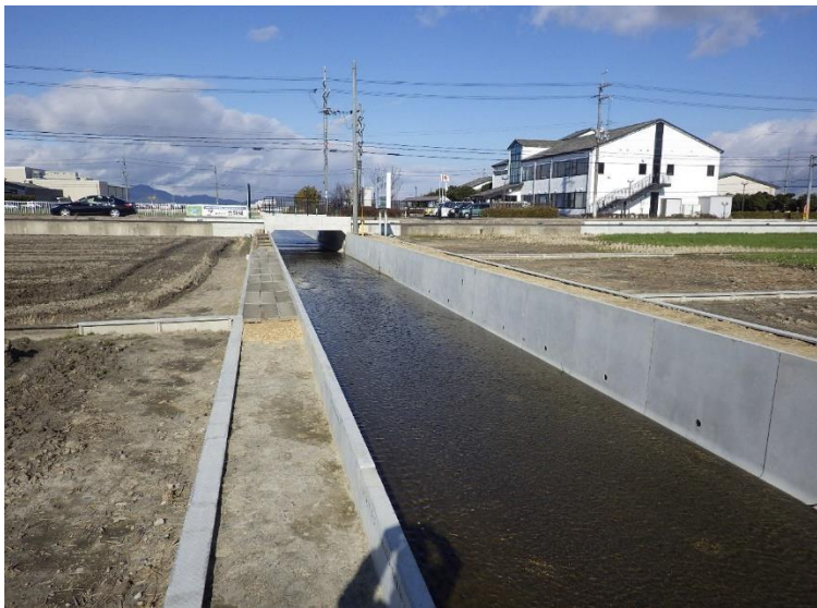
都市排水対策(雨水幹線整備)
