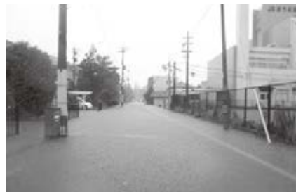
8月16日の大雨で氾濫した妓王井川（野洲駅南口周辺）
