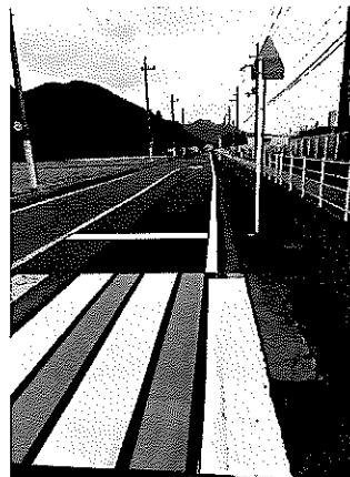
県道小島野洲線(504号)を約250m再舗装していただきました。これは「雨の日に水たまりができて車両が通る度に、通学路を通る子どもたちに水しぶきがかかるから、何か対策をしてほしい」と市民からのご相談でした。
