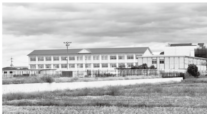
中主小学校大規模改修工事
