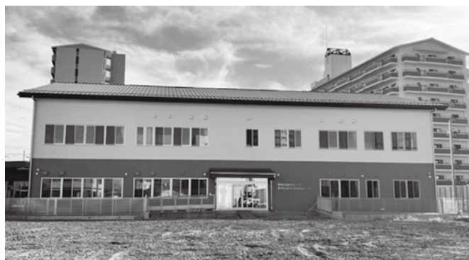
発達支援センター新築工事
