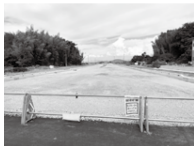
工事が進む大津湖南幹線
