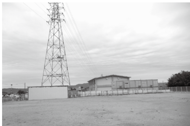
野洲市民病院 整備予定地
