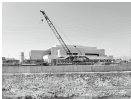
新病院工事が開始された総合体育館横の現場
