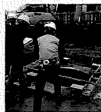
杭の打設完了。セメント固化を待つ。
