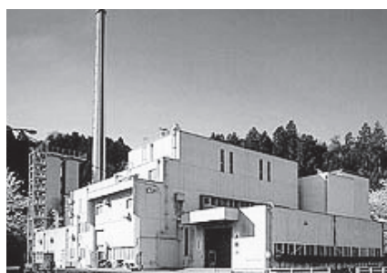
野洲クリーンセンター
