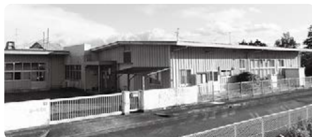
解体が予定されている桜橋会館
