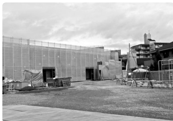
建設中の「ゆきはたこども園」
