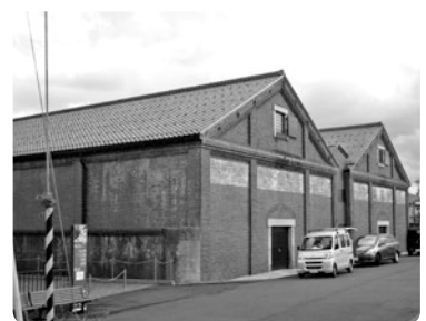
敦賀赤レンガ倉庫
