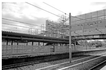
改築が進む篠原駅の駅舎
