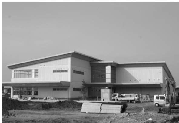
コミュニティーセンターひょうず建設工事(六条地先)
