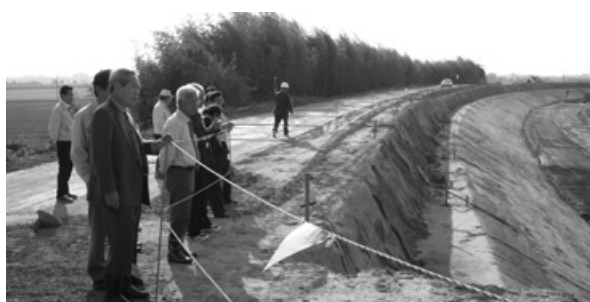
現地視察(日野川改修工事)
