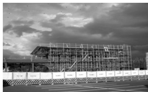
建設中のなかよし交流館
