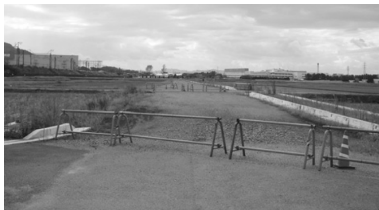
平成20年供用開始予定の農道
