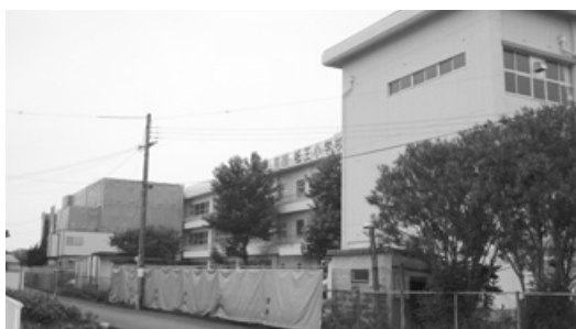
改修の進む祇王小学校
