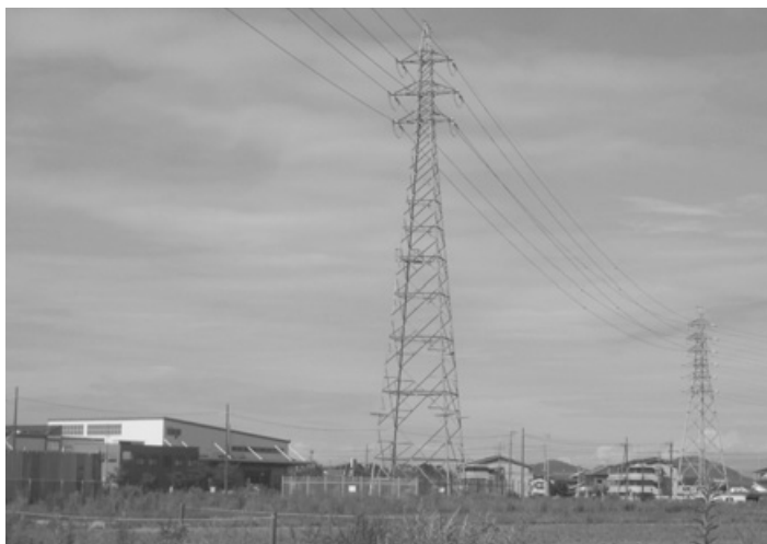
工業団地内鉄塔
