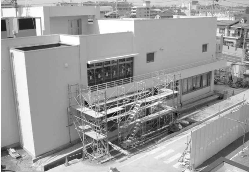
工事中のコミュニティセンターやす
