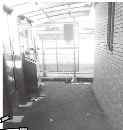
野洲駅南口喫煙所
