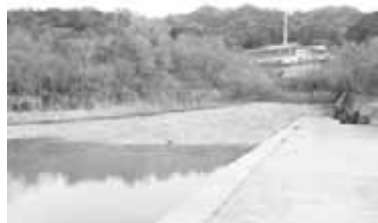
クリーンセンター沈砂池
