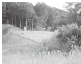
八幡川砂防堰堤
