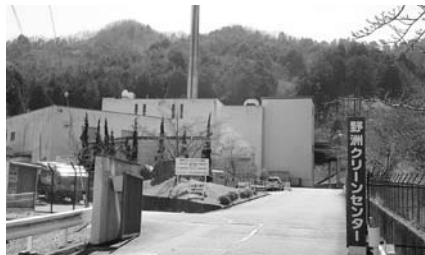
建て替えが予定される野洲クリーンセンター
