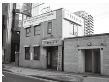
地域安全センターと公衆トイレ
