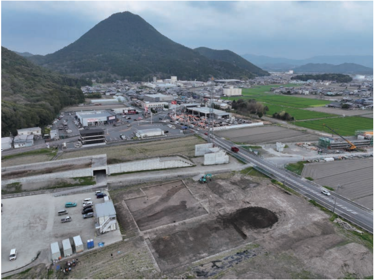
写真1 調査地遠景（北西から）
