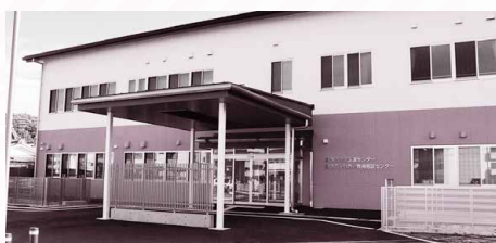
発達支援センター駐車場等工事
