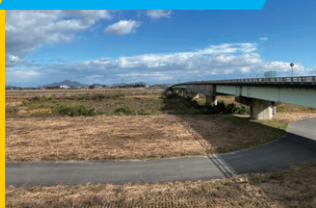
野洲川新庄大橋(平常時)
