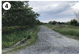
④ 菖蒲線 バイパス整備 (堤地先)
