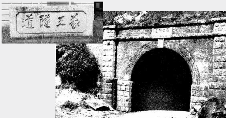
(上)「義王隧道」の銘板
